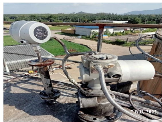
ภาพที่ 4 เครื่องวัดระดับ low Level transmitter และ High Level transmitter ของถังเก็บสำรองเอทานอล
